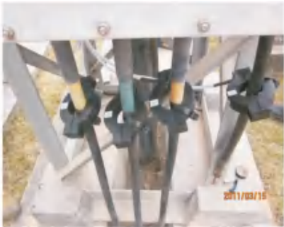
监测三项接地电流及总接地电流的电流传感器
