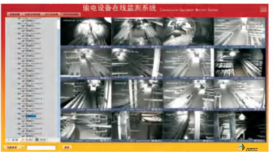
电缆隧道实时监控页面
