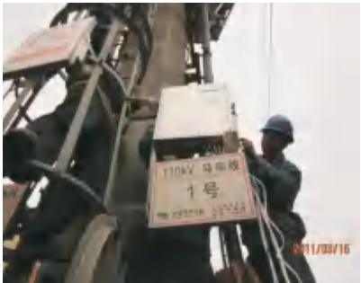
某变电站安装集中控制单元
